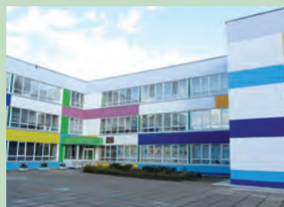
Здание школы после капитального ремонта
