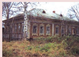
Старое здание школы
